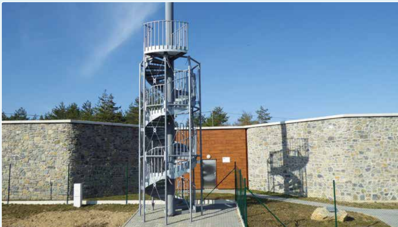
Vodojem s rozhlednou Mokrá
