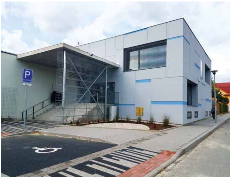
Zrekonstruované provozní středisko v Ivančicích
