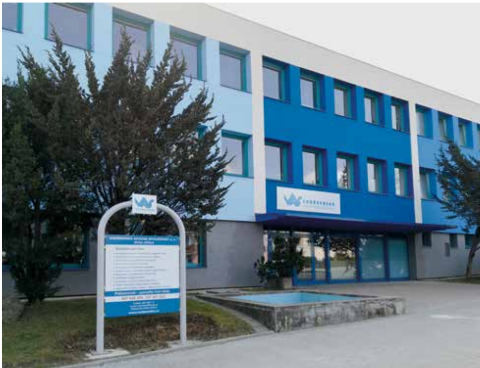
Zrekonstruovaná budova divize Jihlava
