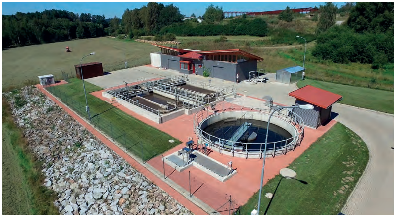
Čistírna odpadních vod Kostelec
