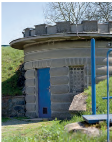
Vodojem Zámek v Letovicích
