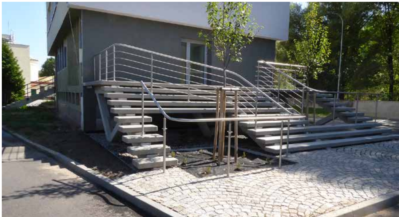
Provozní budova na čistírně odpadních vod v Třebíči
