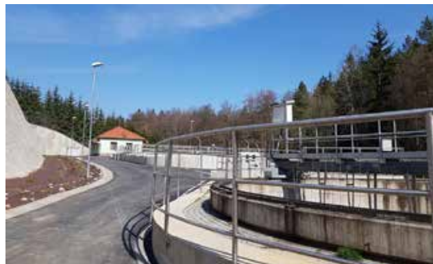
Čistírna odpadních vod v Jedovnicích
