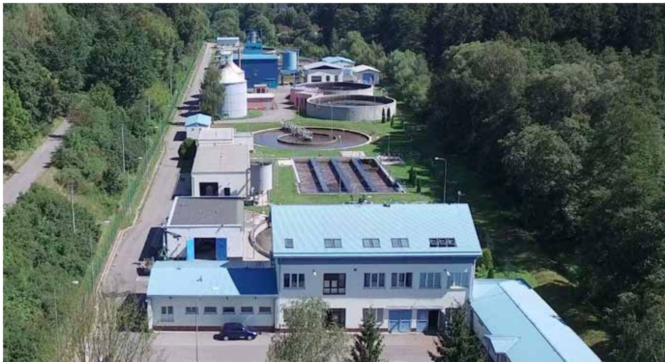
Čistírna odpadních vod v Jihlavě
