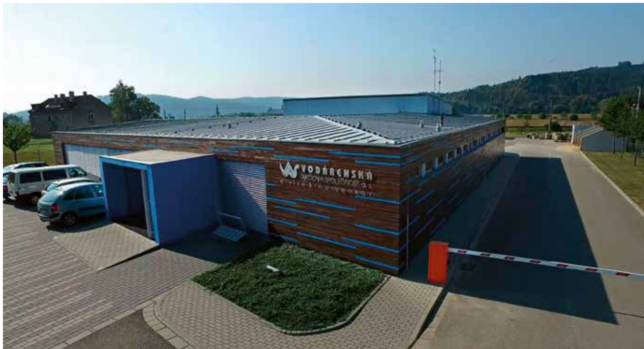
Provozní středisko v Tišnově
