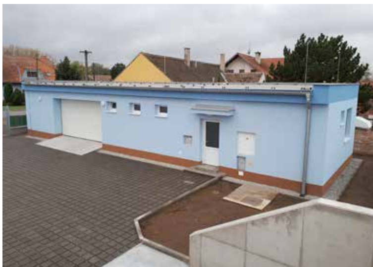
Provozní středisko v Hevlíně
