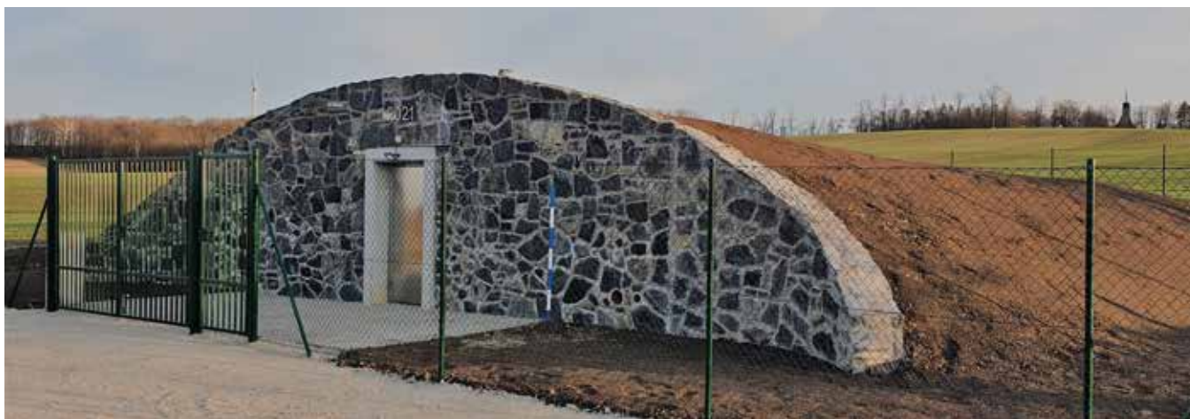
Vodojem Prace nedaleko Mohyly míru na Brněnsku
