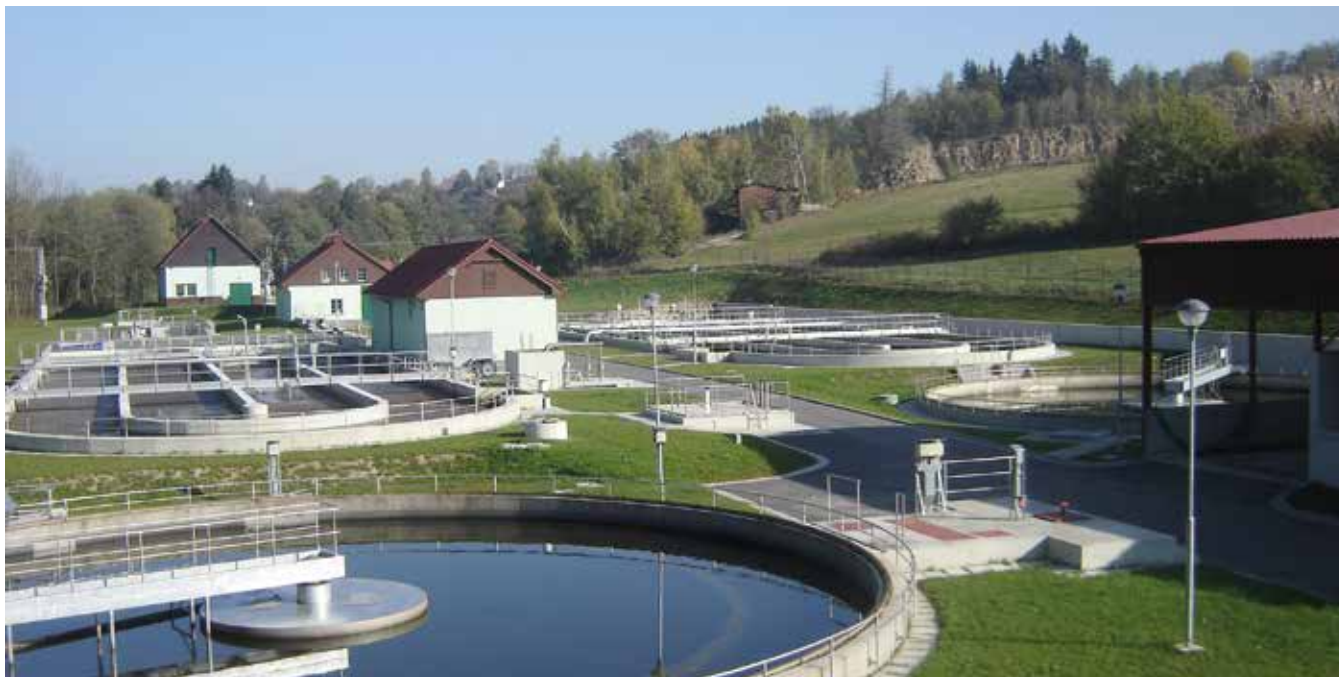
Čistírna odpadních vod v Novém Městě na Moravě
