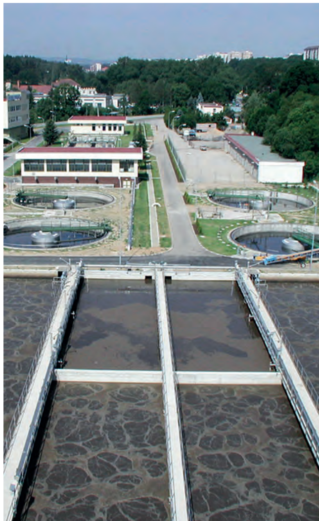
Čistírna odpadních vod Třebíč, která se objevuje i ve zmíněném filmu
