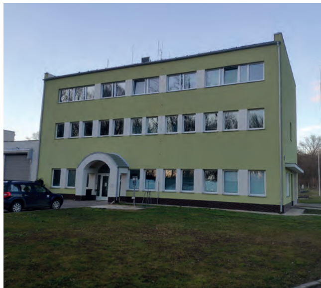
Provozní budova ČOV Znojmo
