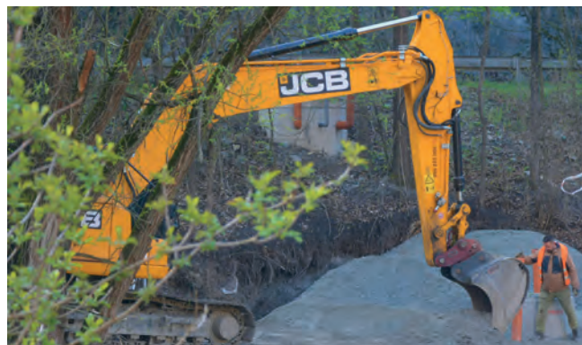
Rekonstrukce výtlačku na ČOV Blansko
