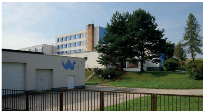
Úpravna vody Nová Říše
