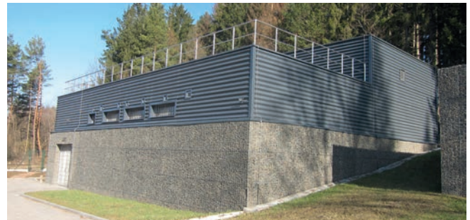
Zrekonstruovaná úprava vody v Jedovnicích
