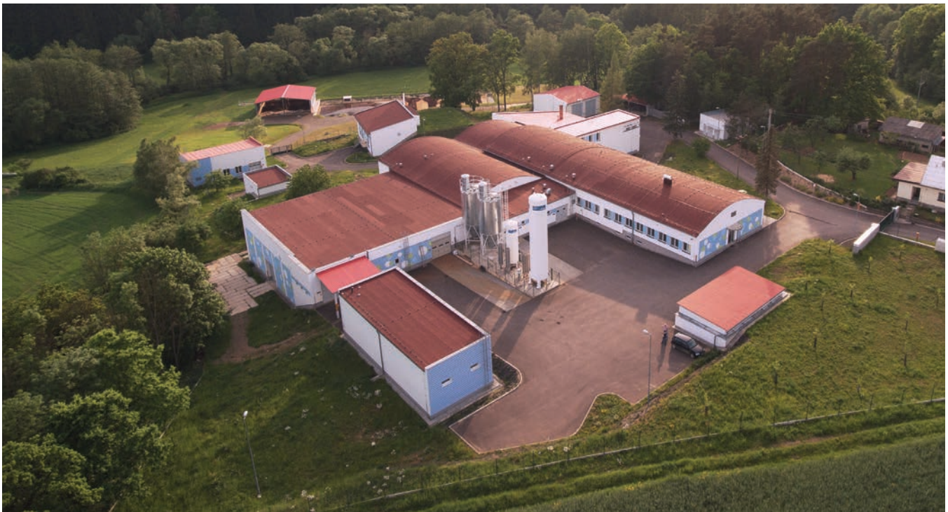
Úprava vody Mostiště
