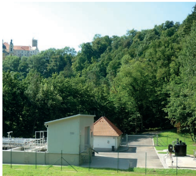
Čistírna odpadních vod Vranov nad Dyjí
