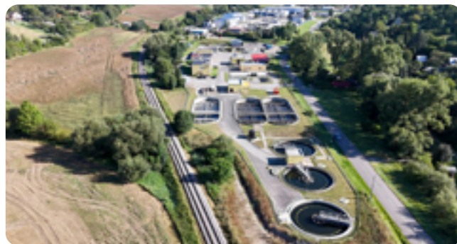
Čistírna odpadních vod Boskovice
