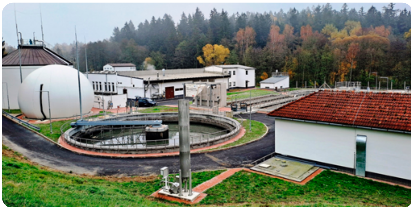
ČOV Žďár nad Sázavou po rekonstrukci
