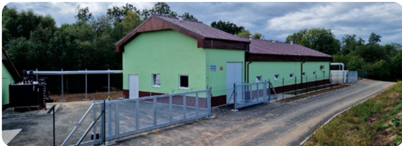
Čistírna odpadních vod Štítary
