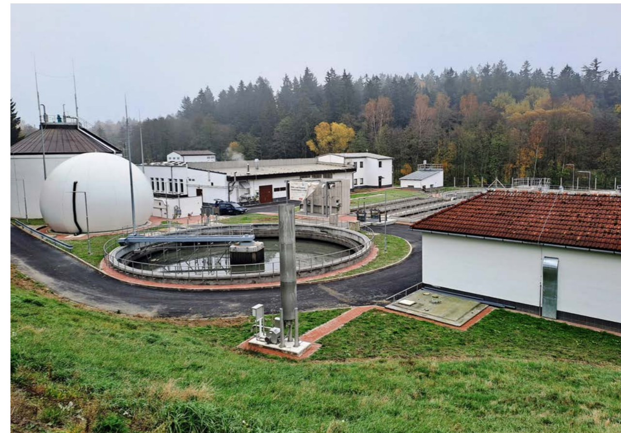
Čistírna odpadních vod Žďár nad Sázavou
