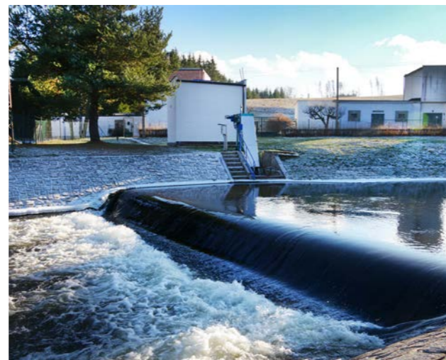
Čerpací stanice Rantířov
