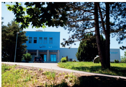
Úprava vody Znojmo po rekonstrukci v roce 2015
