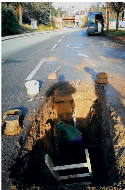
Výkopové práce probíhaly na ulici Havlíčkova
