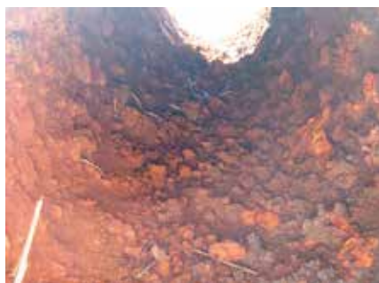
Ocelové potrubí před cementací
