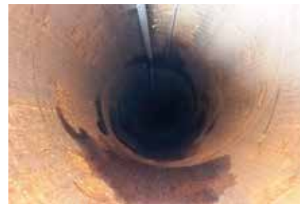
Vyčištěné ocelové potrubí
