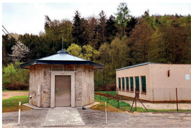
Čerpací stanice je situována přímo v obci
