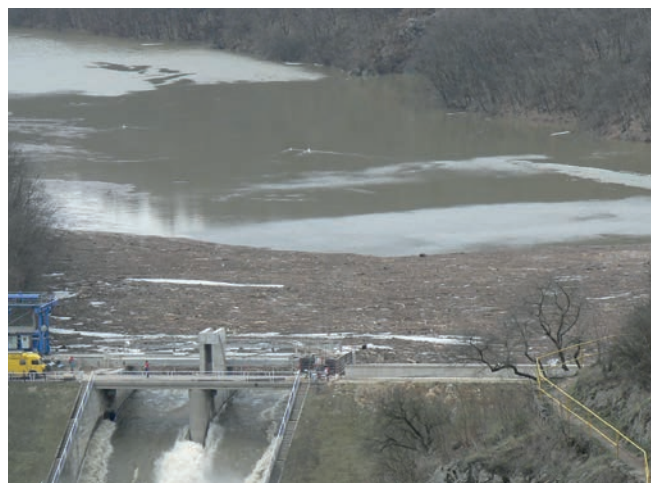
VN Znojmo znečištěná naplaveným dřevem
