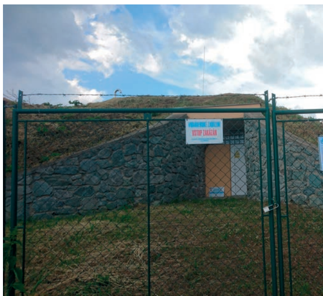
Vodojem Dlouhá Lhota bylo možné navštívit v 1. etapě
