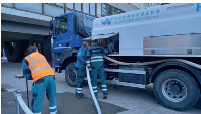
Připojení cisterny na hydrant vnitřního rozvodu a kontrola redukčního ventilu
