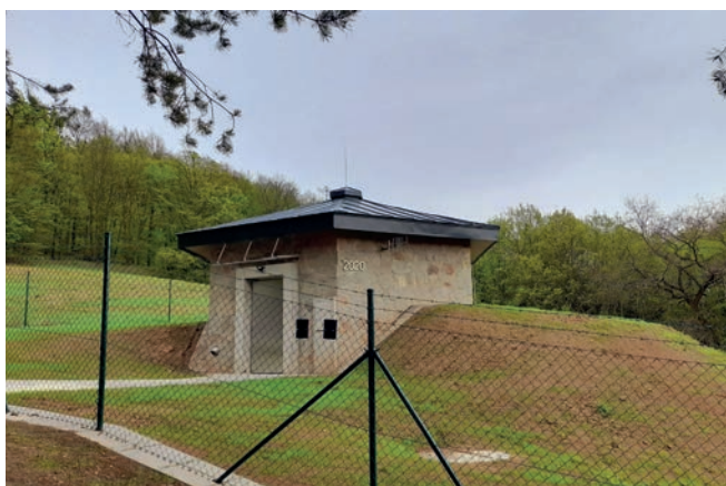
Nový vodojem má akumulaci 2x 100 m 3
