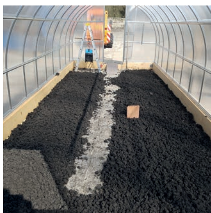
Čistírenský kal se suší v solární sušárně
