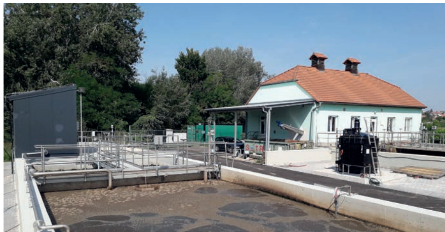
Intenzifikace stávající ČOV Hodonice zahrnovala přístavbu třetí biologické linky
