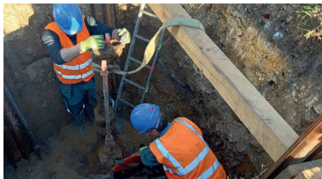
Práce na potrubí vedoucím od Městského lesíku
