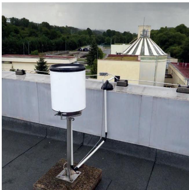
Srážkoměr osazený na čistírně odpadních vod v Třebíči
