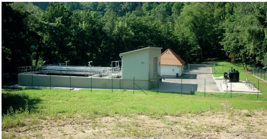
Na ČOV Vranov nad Dyjí vznikl víceúčelový objekt s uspořádáním dvou linek aktivačních a dosazovacích nádrží
