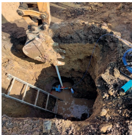
PipeMic při dohledávání poruchy v Kyjovicích
