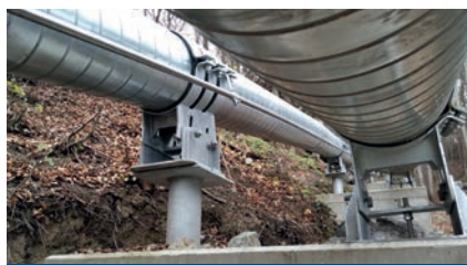
Uložení nadzemního vedení potrubí
