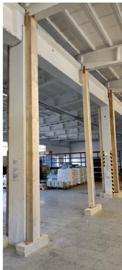
Z důvodu bezpečnosti při vyklizení byl sklad MTZ vyztužen dřevěnými trámy
