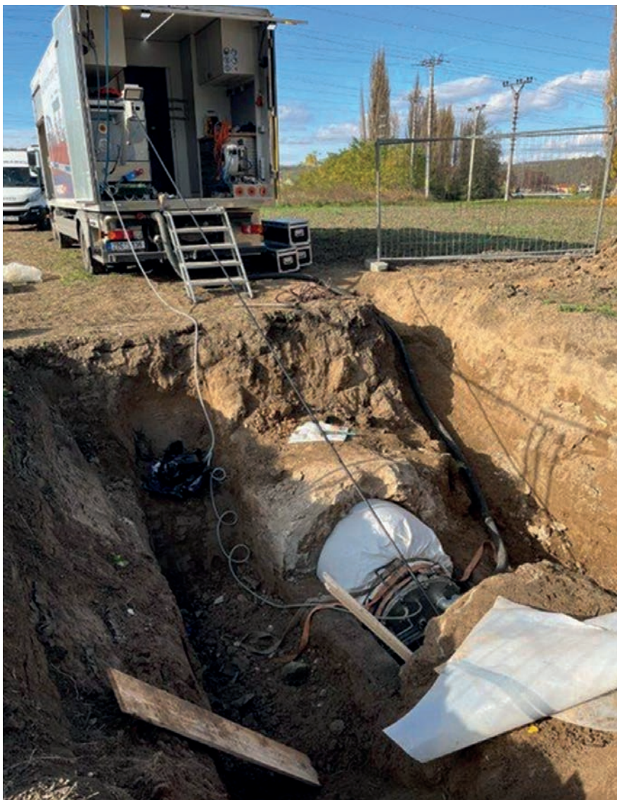
Oprava kanalizace byla provedena bezvýkopovou metodou a technologií UV LINER
