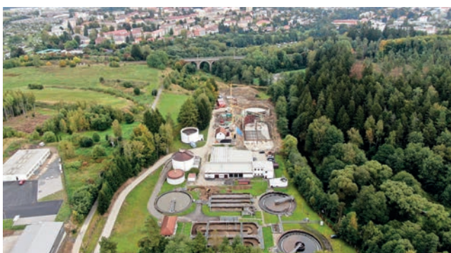
Celkový pohled na probíhající rekonstrukci
