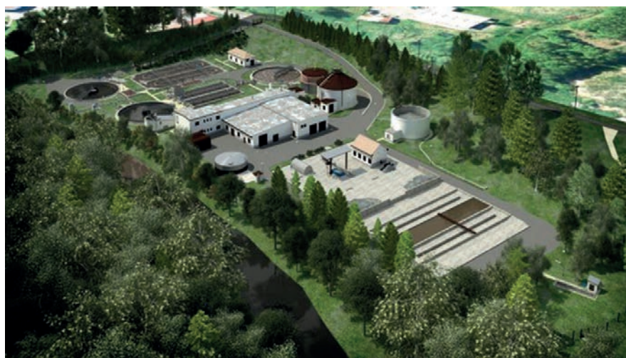
Původní nevyhovující stav čistírny odpadních vod
