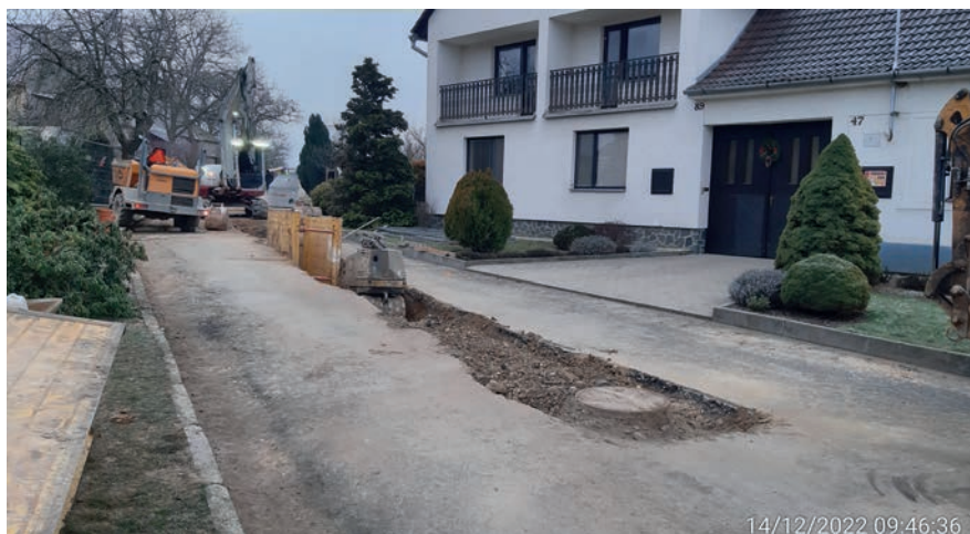
Nově zbudovaná kanalizace v obci Bezkov bude napojena na čistírnu odpadních vod Cítönice
