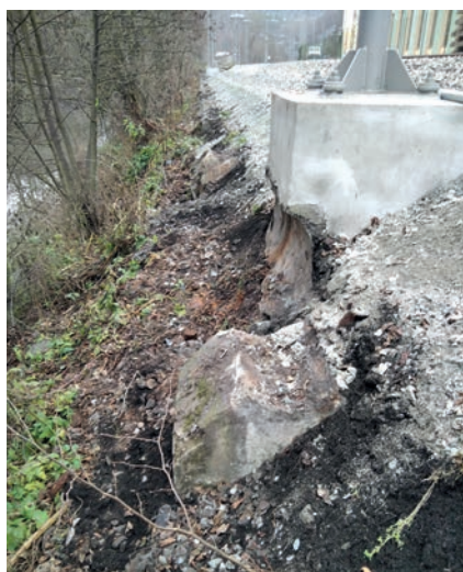
Patka trakčního vedení po odstranění původního kanalizačního výtlaku
