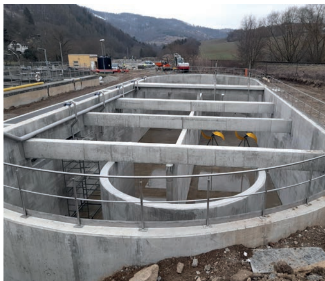
V rámci projektu byla vybudována nová aktivační nádrž
