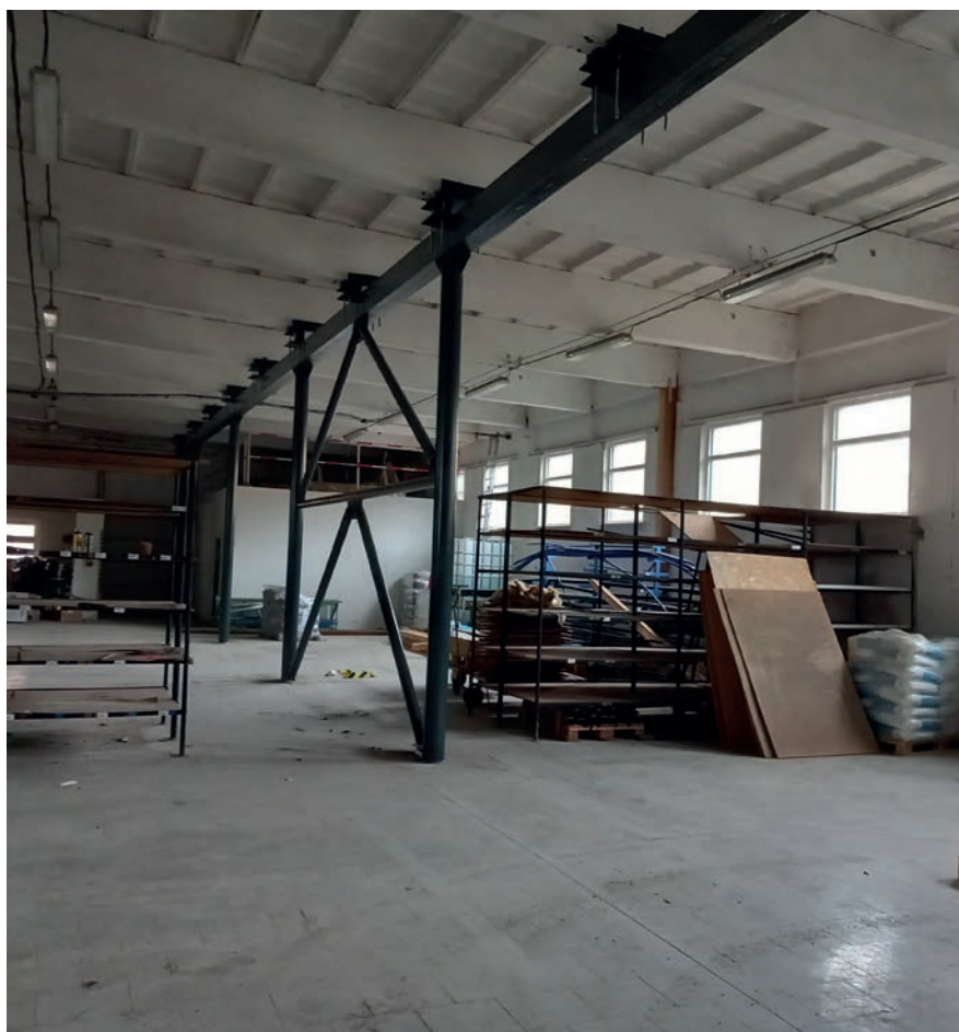
Řešením opravy bylo vytvoření ocelové nosné vestavby do stávající skeletové konstrukce
