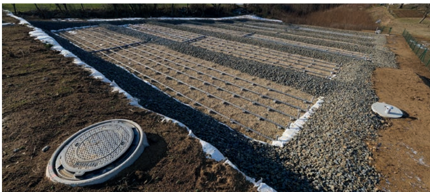
Čištění odpadních vod je založeno na původním konceptu kořenových čistíren
