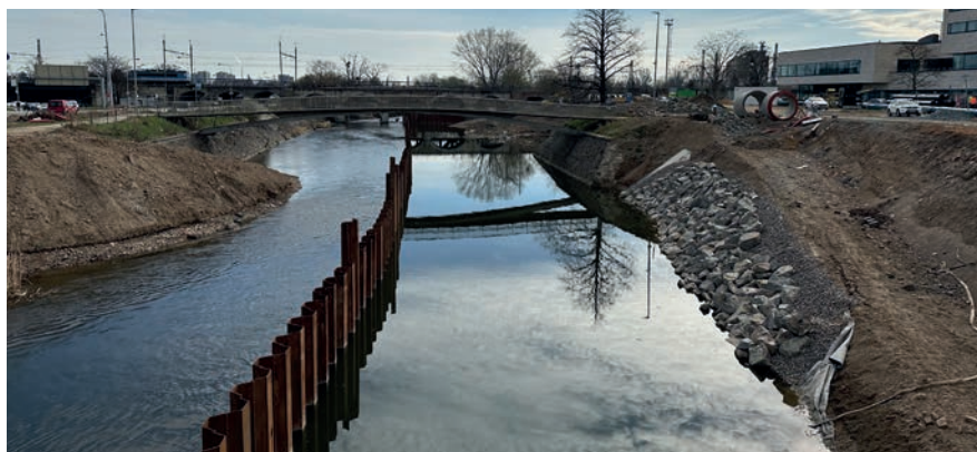
V rámci odborných exkurzí v Brně byla mimo jiné i realizace protipovodňových opatření v Pisárkách a Štýřicích
