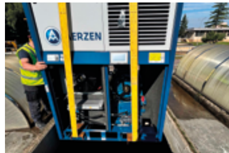
Instalace nového dmychadla
