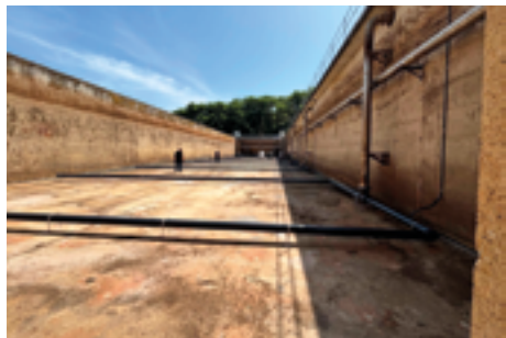
Instalace nového aeračního systému
