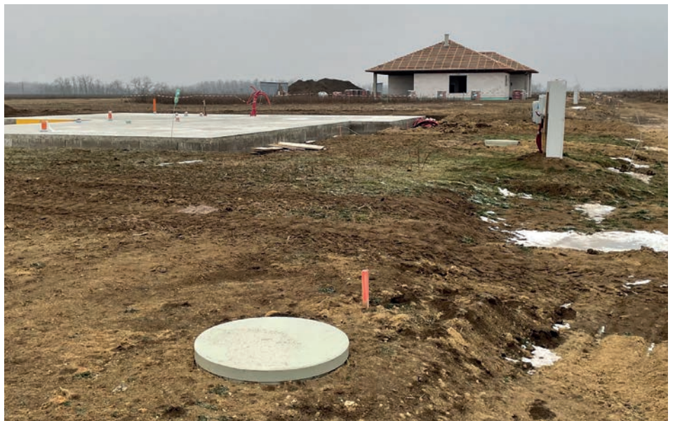
Božice - vybudována kompletní vodovodní a kanalizační infrastruktura
