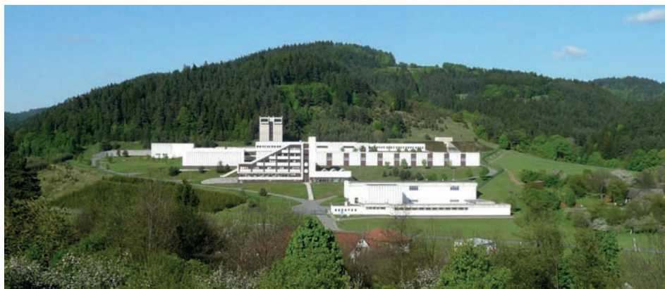
Úpravna vody Švařec
