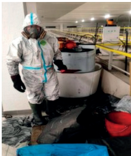
Dávkování práškového aktivního uhlí
