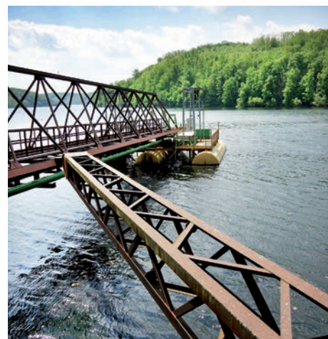
Součástí projektu propojování vodárenských soustav je i návrh na řešení odběru surové vody z vodní nádrže Vranov, který v současné době zajišťuje plovoucí ponton
