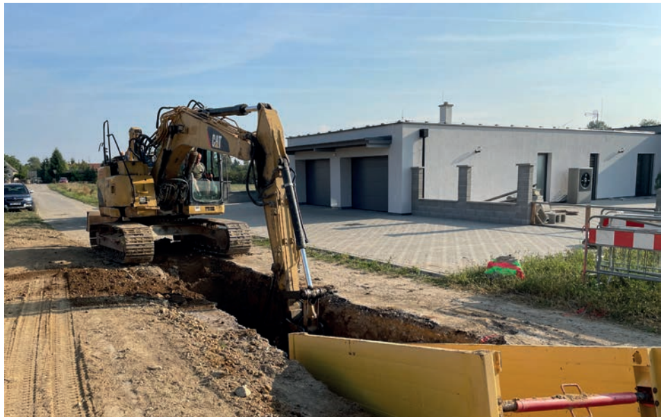
Štítary - práce na zasítování pozemků pro novou výstavbu
